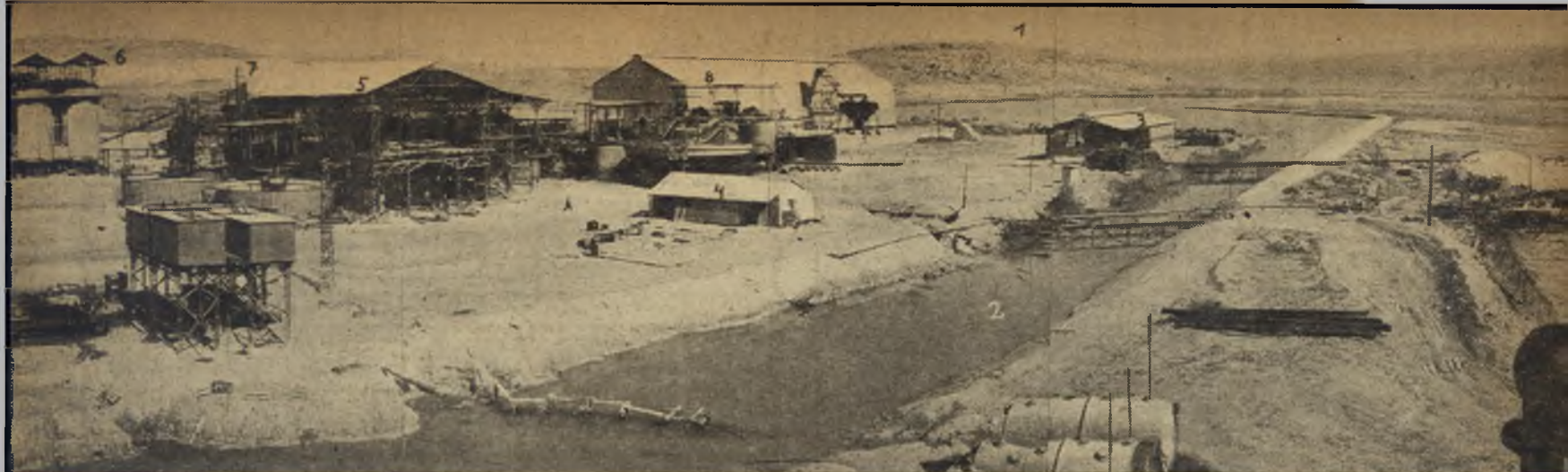
(2) התעלה הגדולה, המעבירה את מייחם אל הבריכות, בעזרת תחנות שאיבה חזקות. אחת מהן היא התחנה מס' 2, הנראית משמאל (10). המעלה את המים מן התעלה אל הבריכות. (3) חדר האוכל. (4) משרד המנהל. מן הבריכות עוברת תמיסת האשלג
