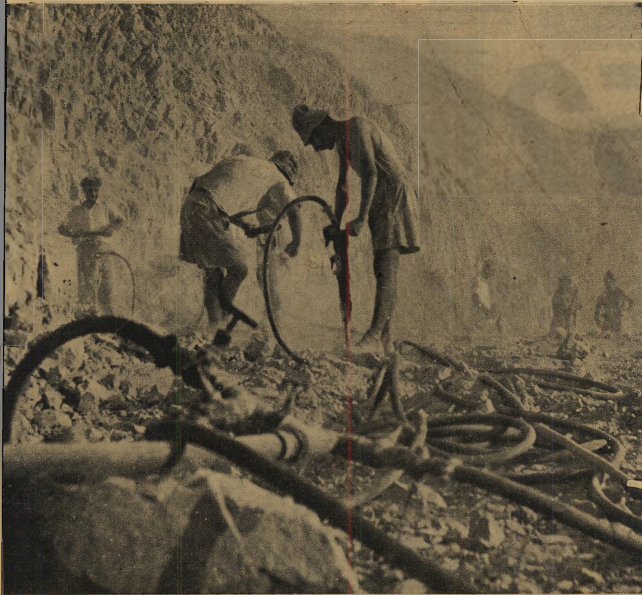
מדירות הכביש. עד לפני שנה וחצי היה זלמן גולדין (41) מהנדס יעירית תל-אביב. מאז עבר לכביש סדום, אחראי שם לעבודות המדידה. תפקידו: לקבוע את גובה הכביש והשיפוע אשר. בו ייסלל
