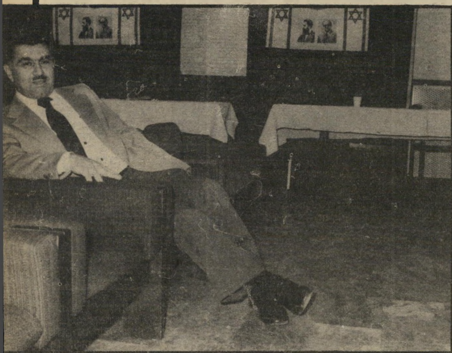
המוכר שר המישפטים, משה ניסים, לא ראה כל פגמים במערכת. הוא הצהיר כי היא מתפקדת כרגיל. לבסוף לא היתה ברירה, אלא למכור את בתי המישפט לכל המרבה במחיר. כאשר נפתחו בתי המישפט מחדש נשמו הכל לרווחה.
