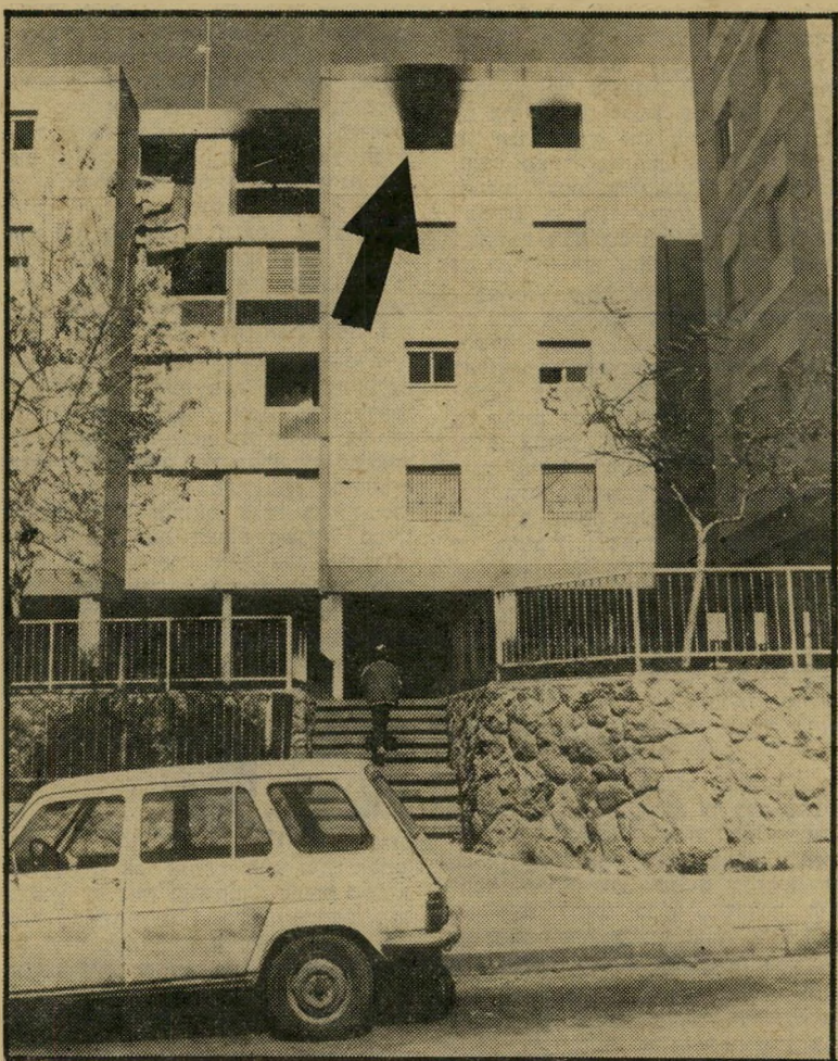
הדירה השרופה ברחוב חלמית 1 ביפו „ראיתי עשן יוצא מהגג, ותרסיסים בוערים עפים“
