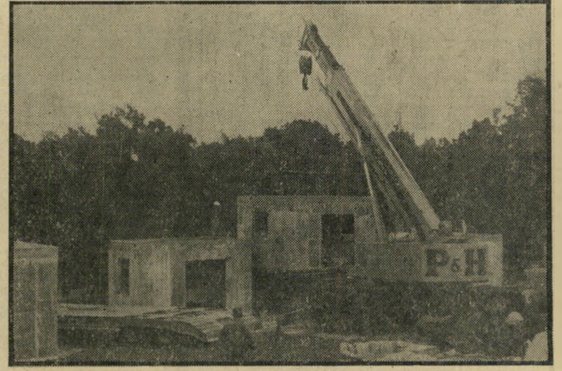
שלב ב' החדר המוכן, הכולל כבר בתוכו ריצוף, טיח, אינסטלציה לחש' מל וכל שאר האביזרים, מועמס על גבי זחל שישא אותו ל' מקום הבנין. בתהליך ייצור המוני יוסע החדר על גבי עגלה מרגע היציקה ועד ההרכבה.
