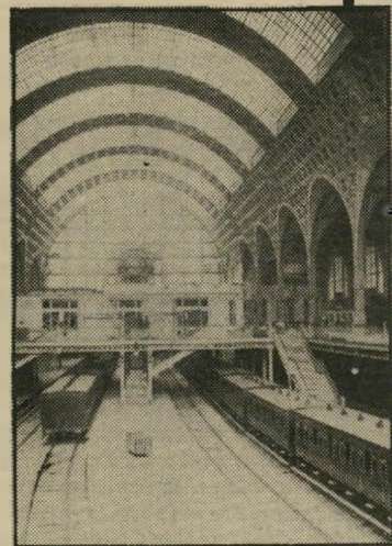
לפני השיפוץ תחנת-רכבת
